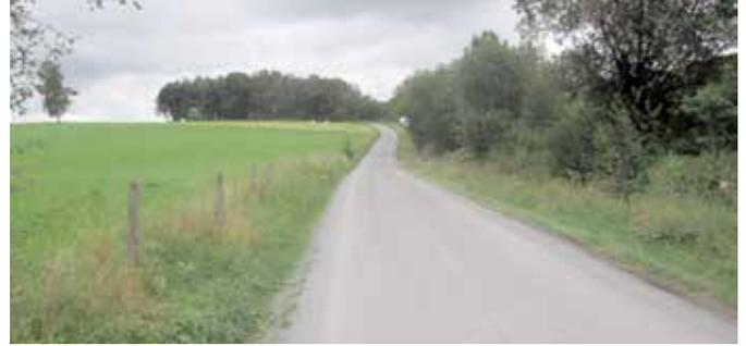
In diesem Sommer haben die Mitarbeiter des Bauhofes eine ganze Reihe von Feldwegen wieder hergerichtet. Nach einer Ausbesserung der Fahrbahn mit Tarmac wurden die Wege mit der gemeindeeigenen Teermaschine überspritzt und mit einer Splittung versehen. In diesem Jahr wurden in Recht, Hünningen und Emfels die geteerten Feld- und Nebenwege wieder aufgefrischt.
