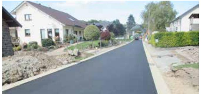
*Verlegung der ersten Asphaltsschicht in der Wehdriggasse.*
