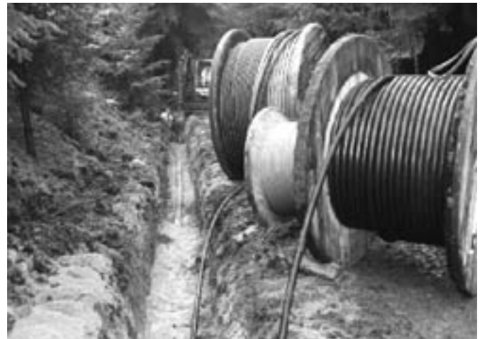
Verlegen der Wasserleitung sowie von Stromkabel Ende November 2004
