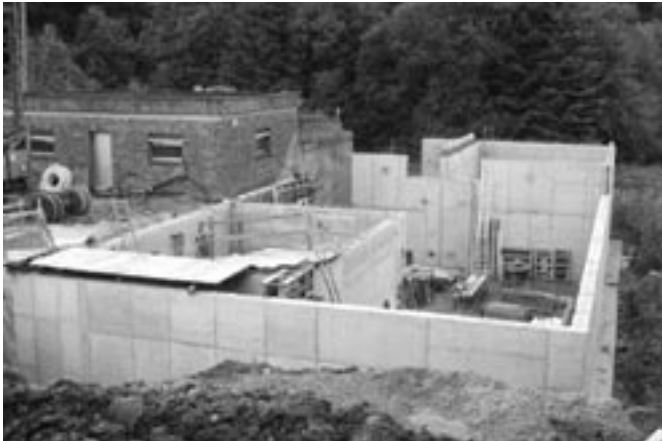
Ein Blick auf die unterirdischen Wände der Becken und Filterhalle aus wasserundurchlässigem Beton
