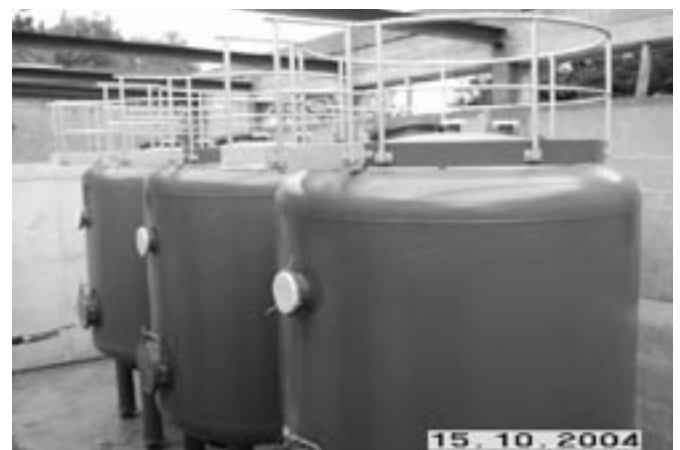
Die Filter: das Herzstück der Aufbereitungsanlage
