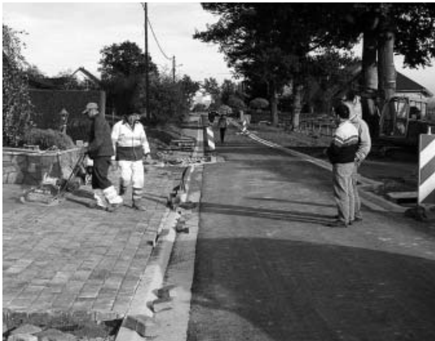
Unser Bild zeigt die Bauarbeiten, ausgeführt durch das Bauunternehmen Maraite aus Halenfeld.
