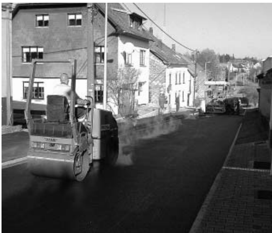
Unser Bild zeigt das Verlegen der Tarmacdecke durch das Unternehmen Bodarwé.
