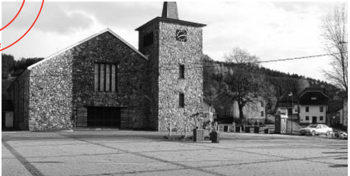
Unser Bild zeigt das Verlegen der Pflasterung auf dem „König-Baudouin-Platz“ in Schönberg.
