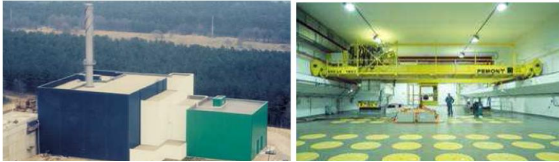
Abbildung 8: Gebäude B136 für die Lagerung von Abfall der Kategorien B und C
