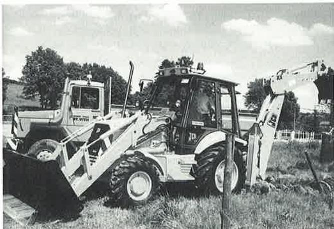
*Unser Foto zeigt den neuen JCB 3CX mit 90 PS Turbomotor im Einsatz beim Einbau des Sandfanges der Kläranlage in Recht.*
