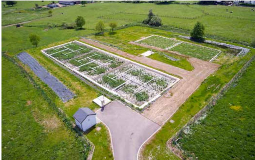
Die biologische Pflanzenklärung beruht auf einem natürlichen Prozess zur Abwasserklärung. Die zum Funktionieren einer biologischen Kläranlage notwendigen Pflanzen sind mittlerweile gut gewachsen und ermöglichen die Klärung des Abwassers auf natürlichem Weg. Sie ist für 760 Einwohnergleichwerte ausgelegt. In den nächsten Jahren wird die AIDE mit Sicherheit dafür sorgen, dass noch mehr Häuser der Ortschaft an die Kanäle angeschlossen werden.
