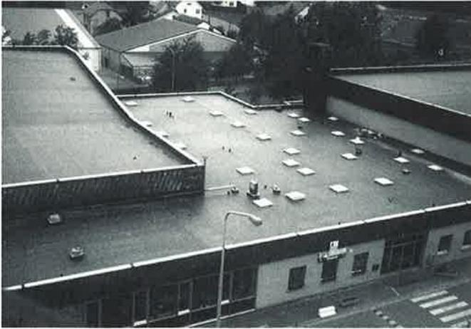
Nach rund 18 Jahren war das Flachdach des Sport- und Freizeitzentrums in St.Vith undicht geworden, so daß eine Instandsetzung unumgänglich wurde.
