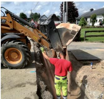
Im Zuge der Erstellung eines Fußweges entlang der Poteauer Straße, verlegte die Firma Bodarwé aus Malmedy 700 m Verteilerleitung. Die Arbeiten wurden im Juli 2017 fertiggestellt. Die Kosten für dieses Projekt belaufen sich auf rund 80.000,- €.
