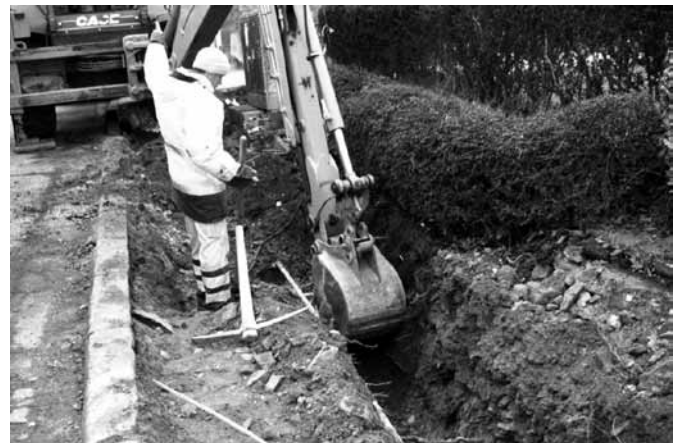
Arbeiter der Firma Vitha Travaux bei Verlegungsarbeiten in der Bahnhofstraße.
