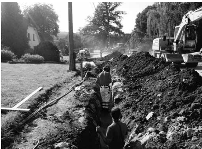
Arbeiter der Firma Bodarwé beim Verlegen der Verteilerleitung in Recht
